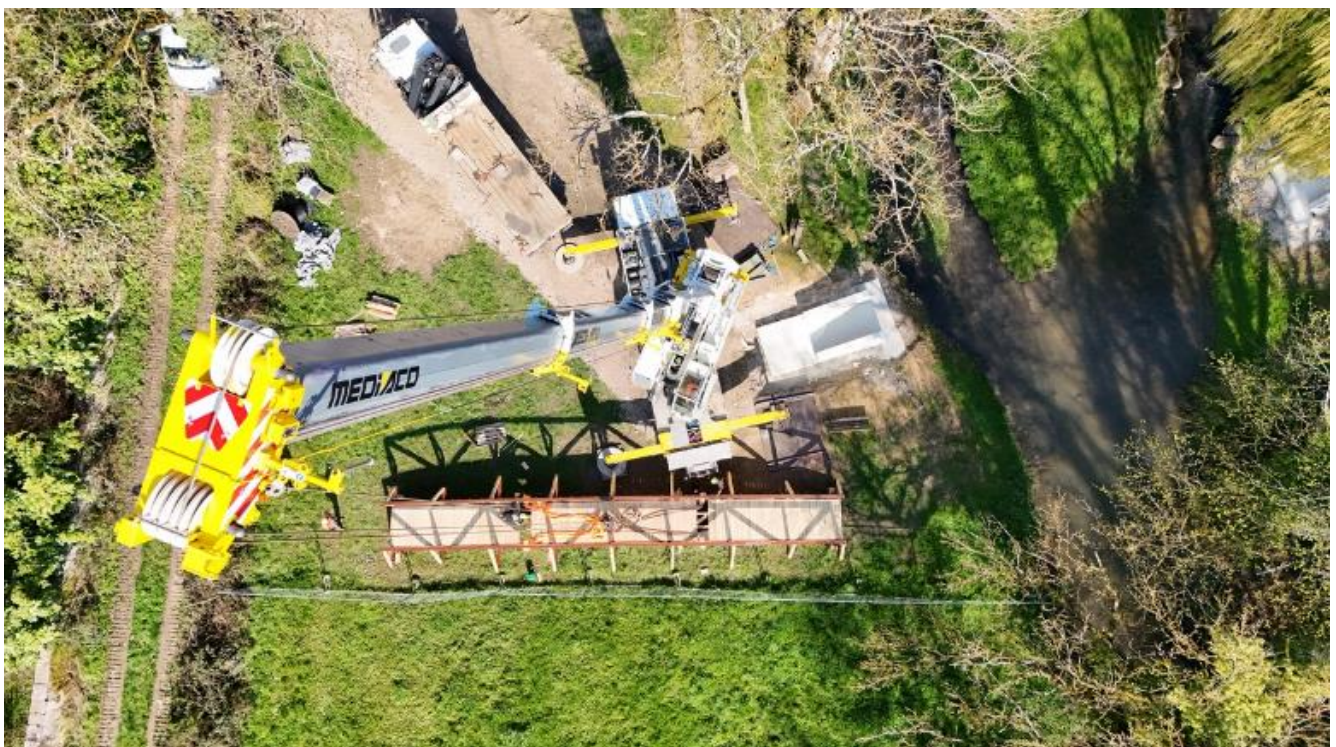
Installation de la nouvelle passerelle (photo prise par drone)
