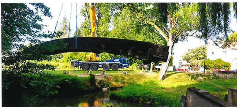
L'ancienne passerelle a ensuite été stockée dans le pré et les charpentiers ont pu la démonter sans encombre ni déchet dans le cours d'eau.
