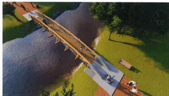
Depuis 2007 grâce à la création de la passerelle surplombant l'Orbize, un cheminement piétonnier permet ainsi de traverser une grande partie de la commune de Dracy-le-Fort. L'esquisse est devenue réalité avec un ouvrage d'une longueur de 18 mètres et de 6 tonnes mélangeant acier et bardage en bois. Avec la succession des aléas climatiques, l'utilisation régulière des administrés, la passerelle s'est progressivement détériorée au fil des ans.
