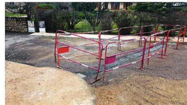
Ceux-ci d'un montant de 12 528 € T.T.C, ont été confiés à la Société EIFFAGE ROUTES. Réalisés du 7 au 10 décembre, ils consistaient à la mise en place d'une grille de 5 mètres en travers de la chaussée, reliée à des tuyaux de 300 mm de diamètre.
